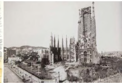
4. Templo Expiatorio de la Sagrada Familia en construcción Fuente: https://laicismo.org
