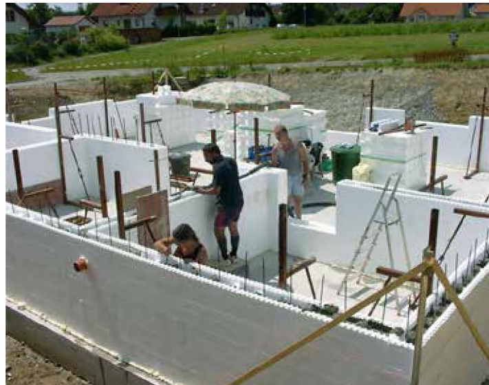
Figura 1. Sistema constructivo no convencional SIMACOM
