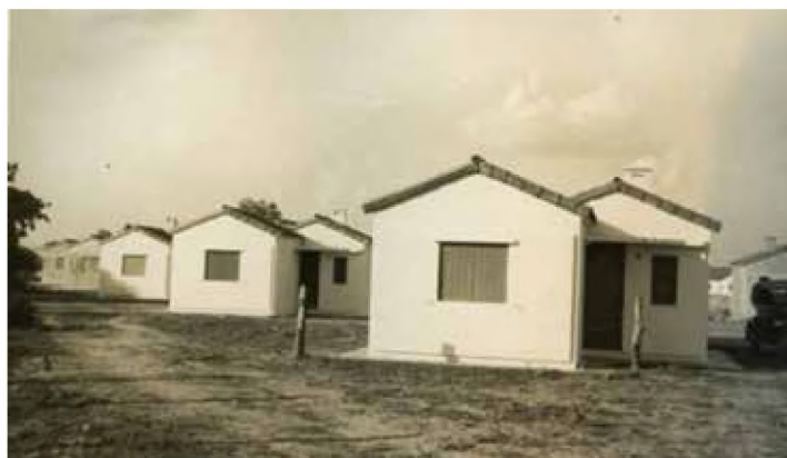
Figura 2. Viviendas prefabricadas del barrio Obrero. Fuente: NEDIM
