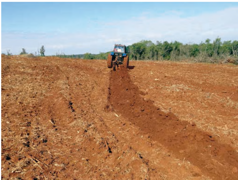
Figura 7: Construcción de la terraza de base angosta de drenaje con arado de disco reversible.
