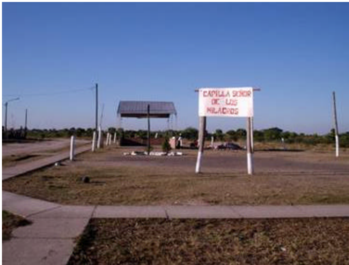
Imagen 5. Se observa el estado en que se encuentra la construcción de la capilla.
