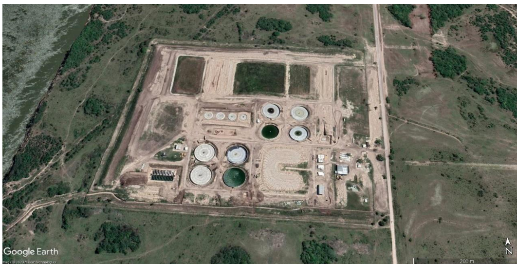
Figura 5. Planta de tratamiento de líquidos cloacales de la ciudad de Corrientes (Fuente: Google Earth).
