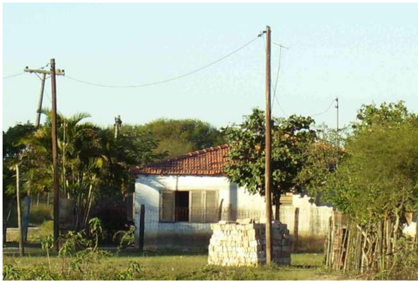
Foto N° 1 Vivienda con rastros del efecto de la inundación
