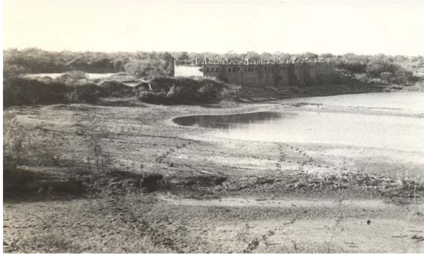
Foto N° 17: Dique sobre el Río Negro que sufrió ruptura en su estructura en 1982.
