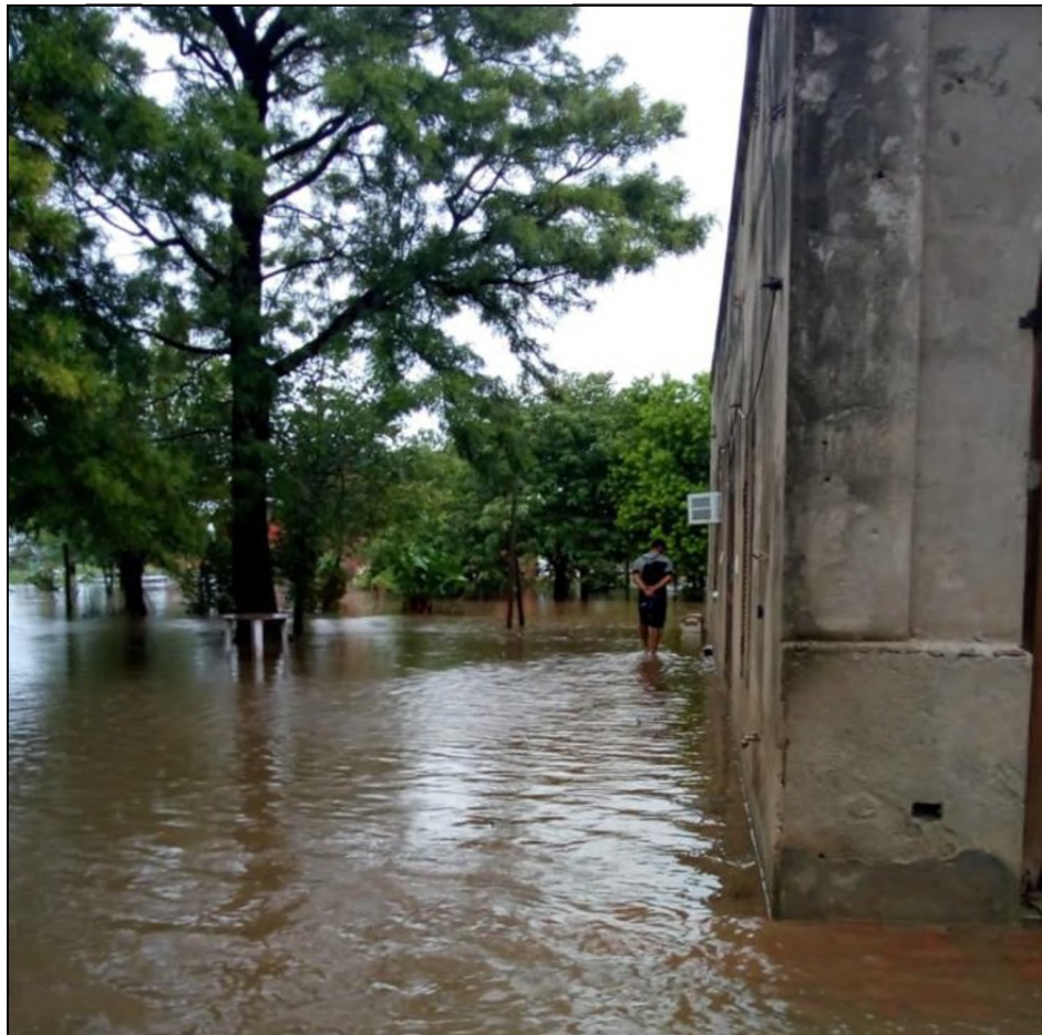
Fig.6 – Fotografía de inundación tomada en Abril del 2020 (Fuente: Vecinos de la Localidad)
