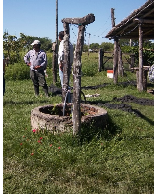
Figura 5: Pozo excavado (con bomba)
