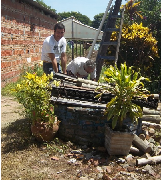
Figura 4: Pozo excavado (sin bomba)
