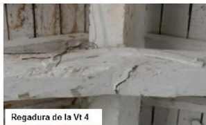
Detalle vigas cumbrera y transversales (S4)
