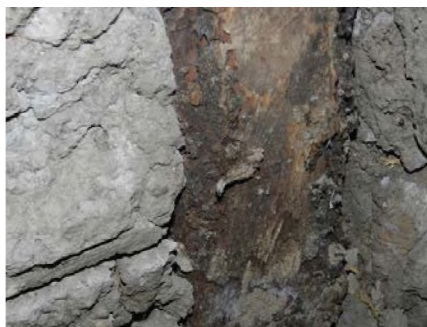
Detalle clavo utilizado para sujeción tacuaras (en vez de tientos tradicionales)
