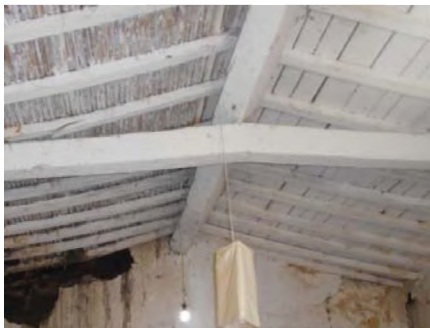
Detalle vigas cumbrera y transversales (S4)
