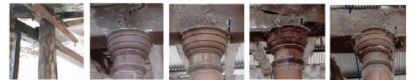
Capiteles de columnas C 13a, C 14a, C 15 a, C 16 a, con regaduras y quiebre en su cuerpo.
