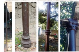
Columna con capiteles de una pieza de hierro fundido correspondiente a del cuerpo agregado posteriormente a la construcción original.
