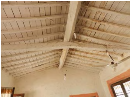
Detalle vigas cumbrera y transversales (S3)
