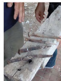
A: Punzón B, C, D: Clavos para sujeción de los encuentros de los cabios en la cumbra y de estos a la viga solera. E: Clavos para sujeción de la tacuara a la estructura vertical del entramado de tronco de los muros
