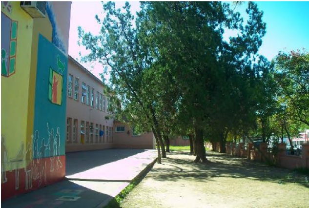
Fronte lateral sobre Avda. Sarmiento. Fuente: Arq. María Elena Fossatti, 2015
