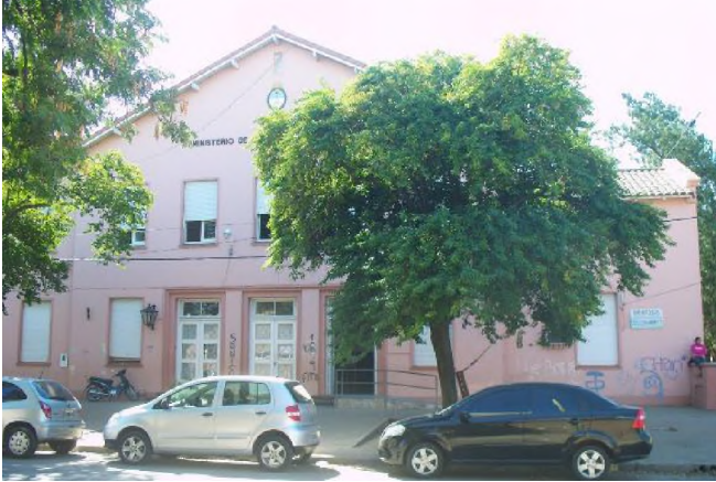
Fronte principal. Fuente: Arq. María Elena Fossatti, 2015
