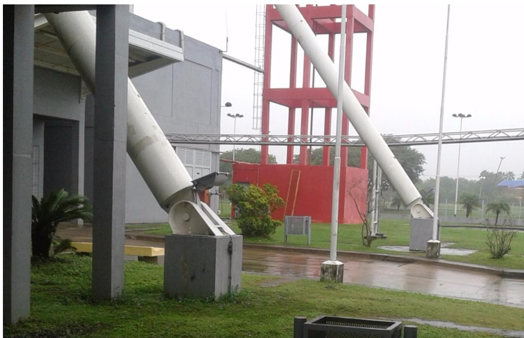
Figura 3.8. Fotografía de las bielas articuladas que forman una suerte de estructura externa complementaria a la principal. Fuente: fotografía tomada durante la visita al estadio.
