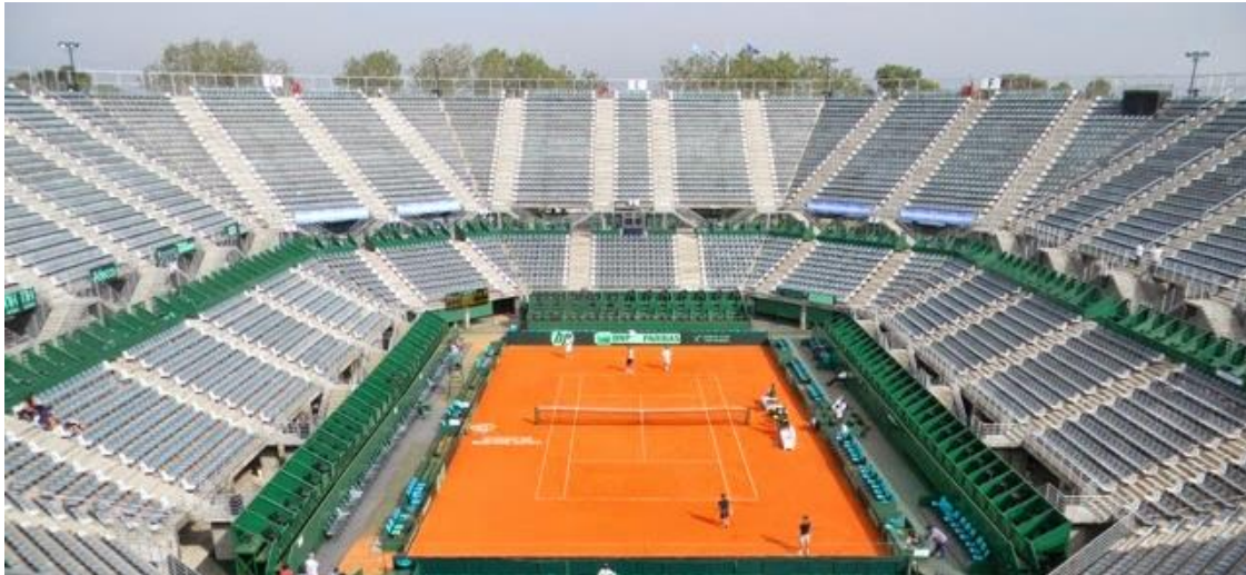
Figura 6.4. Tribunas del estadio Parque Roca, construidas con elementos estructurales prefabricados. Fuente: https://4.bp.blogspot.com/-IjJT49E_Chc/U43Ufiz_OhI/AAAAAAAAADmI/JDRtJUc3mtA/s1600/proca2.jpg
