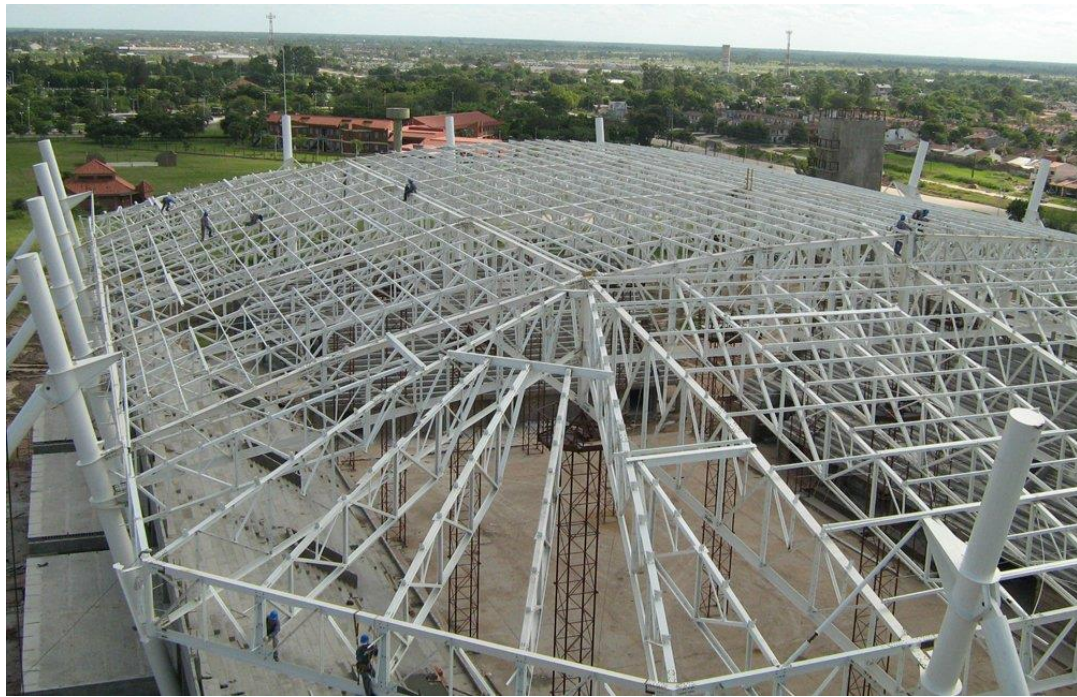
Figura 3.7. Fotografía de la estructura metálica de la cubierta del estadio. Fuente:
