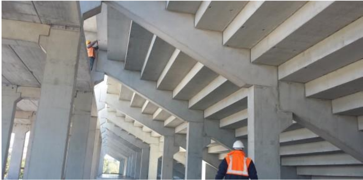
Figura 6.6. Vigas, columnas y losas prefabricadas montadas en obra. Fuente: sitio web de la empresa Farcimar S.A.. http://farcimar.pt/pt/
