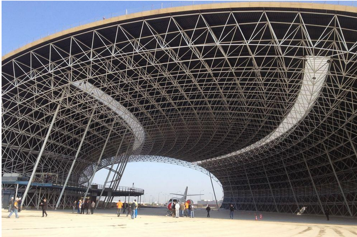
Figuras 6.22 & 6.23. Fotografías de la malla espacial que soporta la cubierta del Museo Aeronáutico de Toulouse. Fuentes: http://www.lanik.com/es/soluciones/estructuras-espaciales & http://www.lepoint.fr
