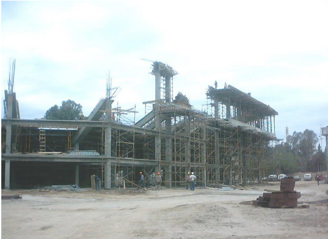
Figura 3.15. Fotografía de la construcción del Orfeo Superdome. Fuente: http://www.orfeosuperdome.com
