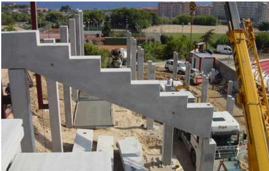
Figura 6.1. Montaje de vigas escalonadas. Fuente: sitio web del Grupo Pujol.
