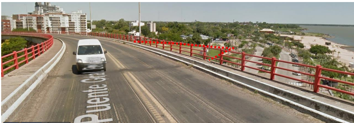
Figura 4.2. Fotografía tomada desde un automóvil en la cual se observa que un conductor proveniente de Resistencia puede identificar el predio desde el puente interprovincial. Fuente: Google Street View (2015).
