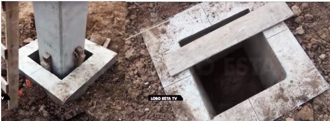
Figura 6.7. Parte superior de una zapata premoldeada, donde apoya la base del pilar. Fuente: Canal Lobo Está TV 2014. YouTube. https://www.youtube.com/user/LOBOESTATV2014
