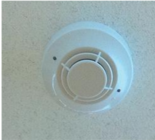
Figura 7.1. Fotografía de un detector de humo. Fuente: http://www.ifci.cas-seguridad.org.ar/noticias/que-son-las-instalaciones-fijas-contra-incendio/
