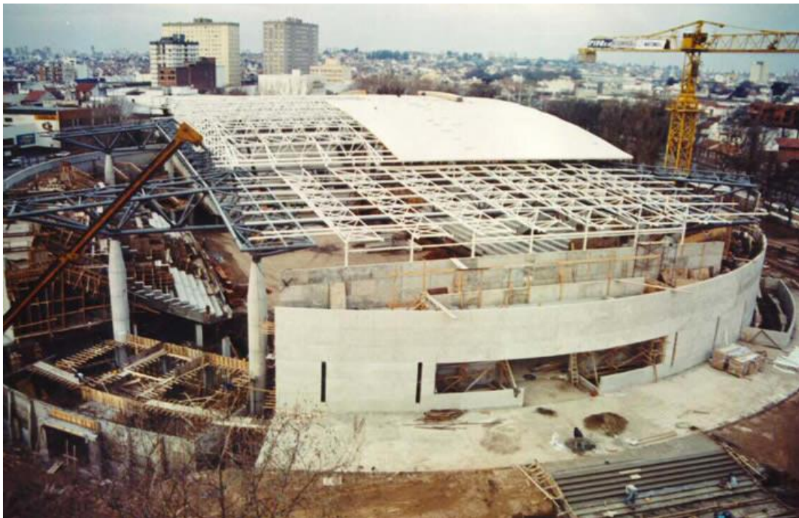
Figura 3.20. Polideportivo Islas Malvinas en plena etapa de construcción. Fuente:
