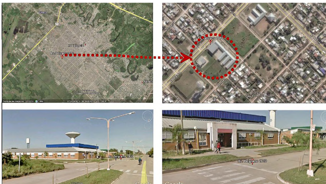
Figuras 1. Vistas aéreas del sector urbano de implantación de la UEP N.º 172 en la ciudad de Resistencia (arriba). Vistas peatonales del acceso a la UEP N.º 172, sobre Av. Belgrano (abajo). Fuente: Google Earth, 2015
