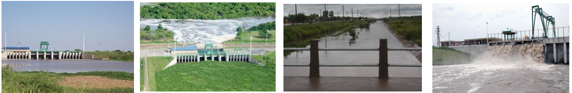
Grafico 25. Dique compensador sobre desembocadura al Riacho Barranqueras. Fuente: propia y APA. Canal de Soberanía luego de copiosas lluvias . Fuente: http://www.chacodiapordia.com . Resistencia, 02/02/12, Año VII, Edición 2568
