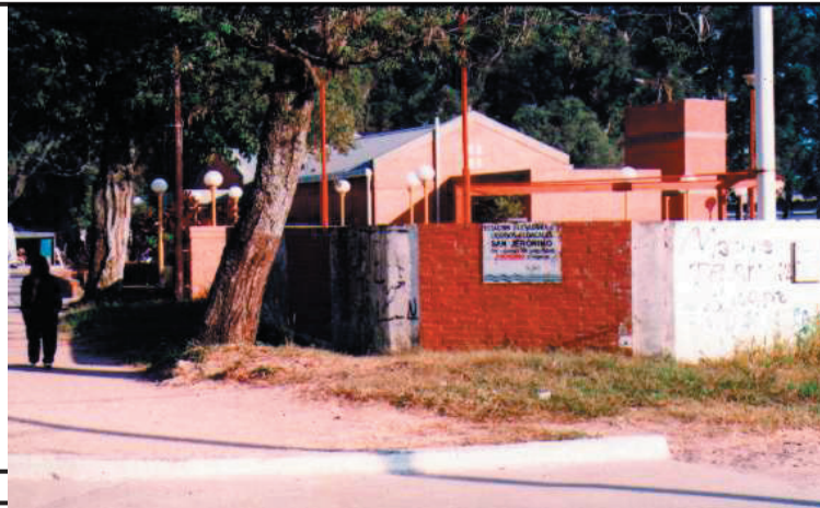
FOTO 14 ESTACION ELEVADORA DE LIQUIDOS CLOACALES EMPRESA AGUAS DE CORRIENTES
