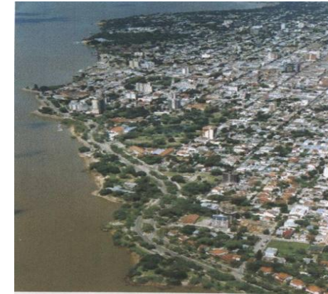
Vista aérea de la Costanera de Corrientes
