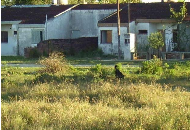
Foto N° 2: Otras viviendas que son ocupadas hoy, con los rastros de la inundación
