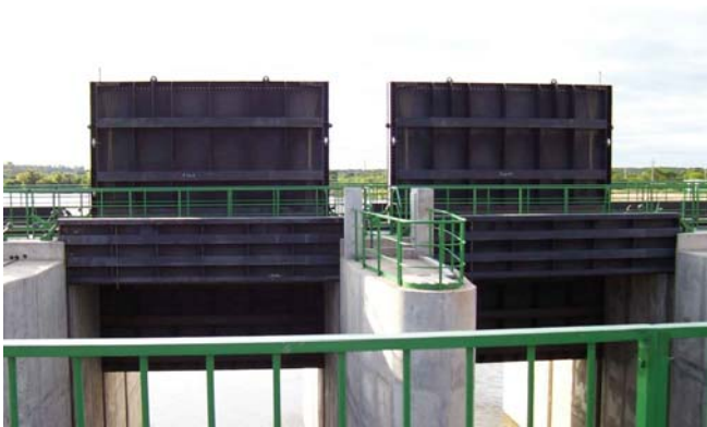
Foto N° 18: Vista del nuevo Dique, con las compuertas levantada y en el fondo el Río Negro.
