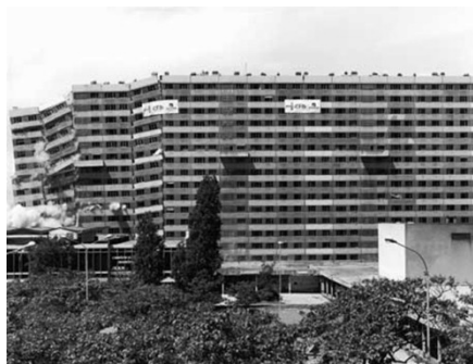
Barre Renoir en la 'Ciudad de las 4000' e La Courneuve (Île de France) Demolición: 2000 (otras demoliciones de bloques de viviendas en La Courneuve: 1986, 2001, 2002, 2003).
