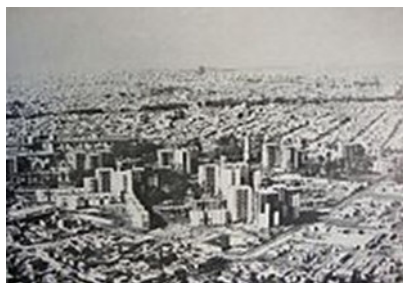
Fuerte Apache. En construcción hacia 1972.
