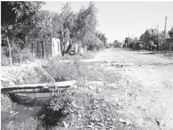
Figura 8. Conexiones informales y precarias Fuente: elaboración propia
