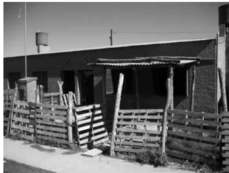
Construcción de techos precarios
