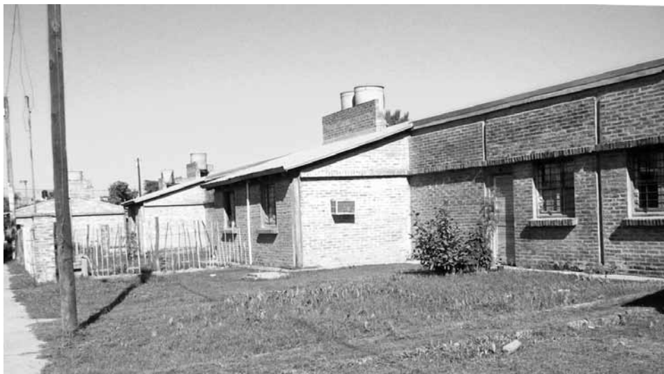
Figura 4. Frente de las viviendas del barrio Vargas II construidas por el programa Fuente: elaboración propia (año 2010)
