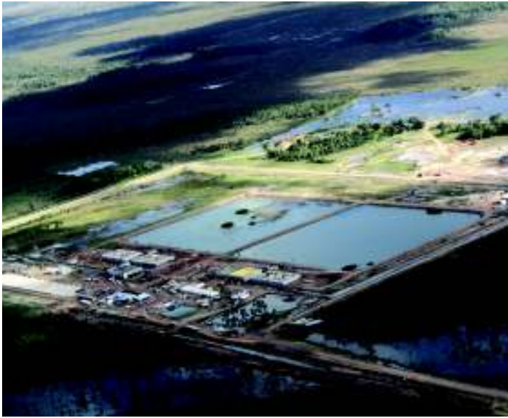
Planta de tratamiento de efluentes cloacales del AMGR
