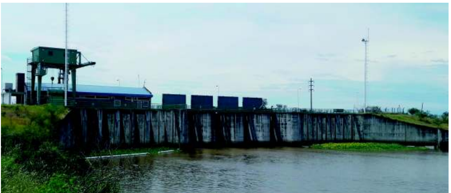
Dique de Defensa. Barranqueras
