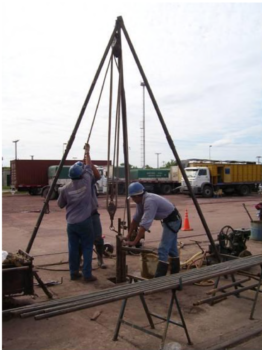
Fotografía N°2: Ejecución sondeo N°2.
