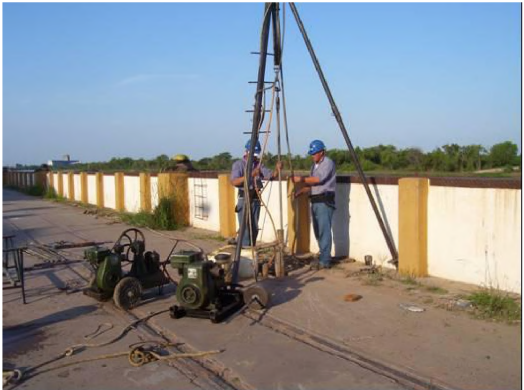
Fotografía N°1: Ejecución sondeo N°1.
