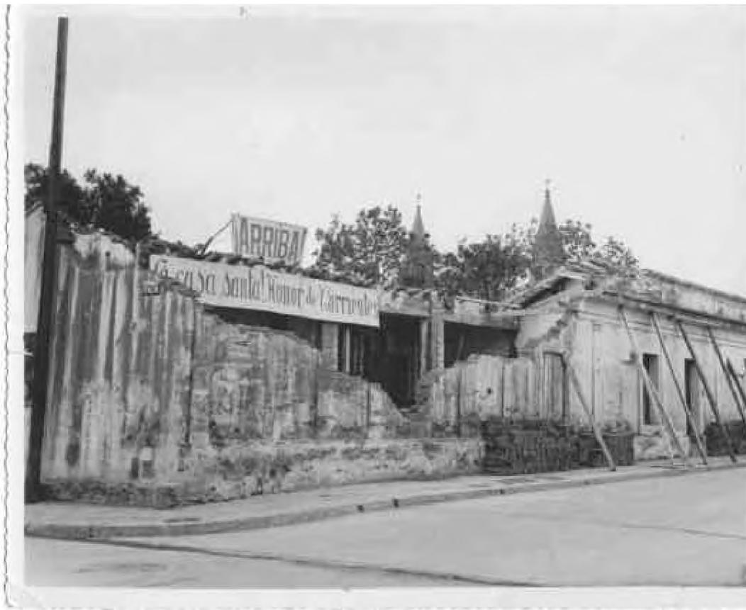
Fotografía donde se observa la superposición de una fachada italianizante a un interior colonial, constatado a través de la diferencia de anchos de muros frontales y laterales, los cuales son de mayor espesor ya que son de estanteo.
