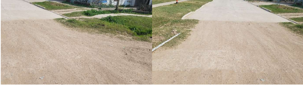
Figura 7 y 8: Vinculación entre calle pavimentadas y enripiadas
