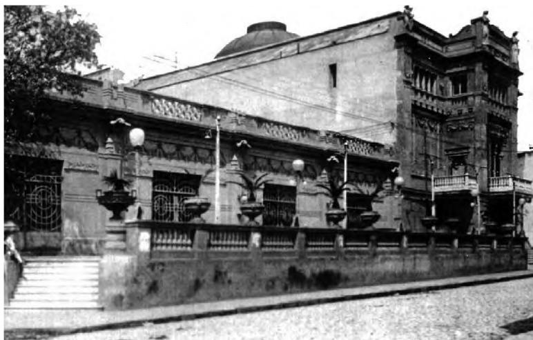
Imag. 17: Nuevo Teatro Vera. Edificio del teatro con su terraza inaugurada en 1914.
