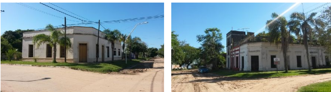
Fotos 4, 5: casas de estilo italianizante sobre la segunda calle paralela al río. Ejemplos aislados, sin continuidad Fotos: V. Valenzuela, 2014.
