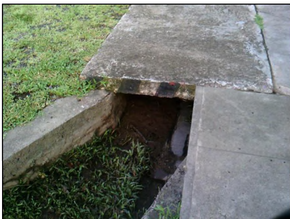
Figura 2.3. Alcantarilla sobre cuneta en calle principal Acceso al Registro Civil
