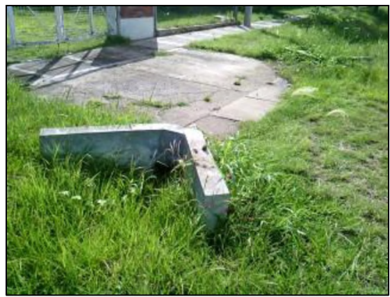
Figura 2.4. Alcantarilla de acceso vehicular a la E.E.S. N° 62 "Mesón de Fierro"
