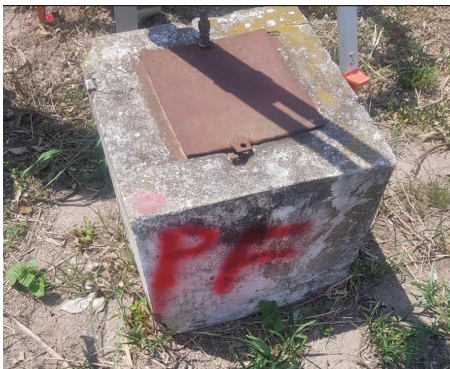
Figura 2.10 Monolito utilizado para materializar el Punto Fijo trasladado.
