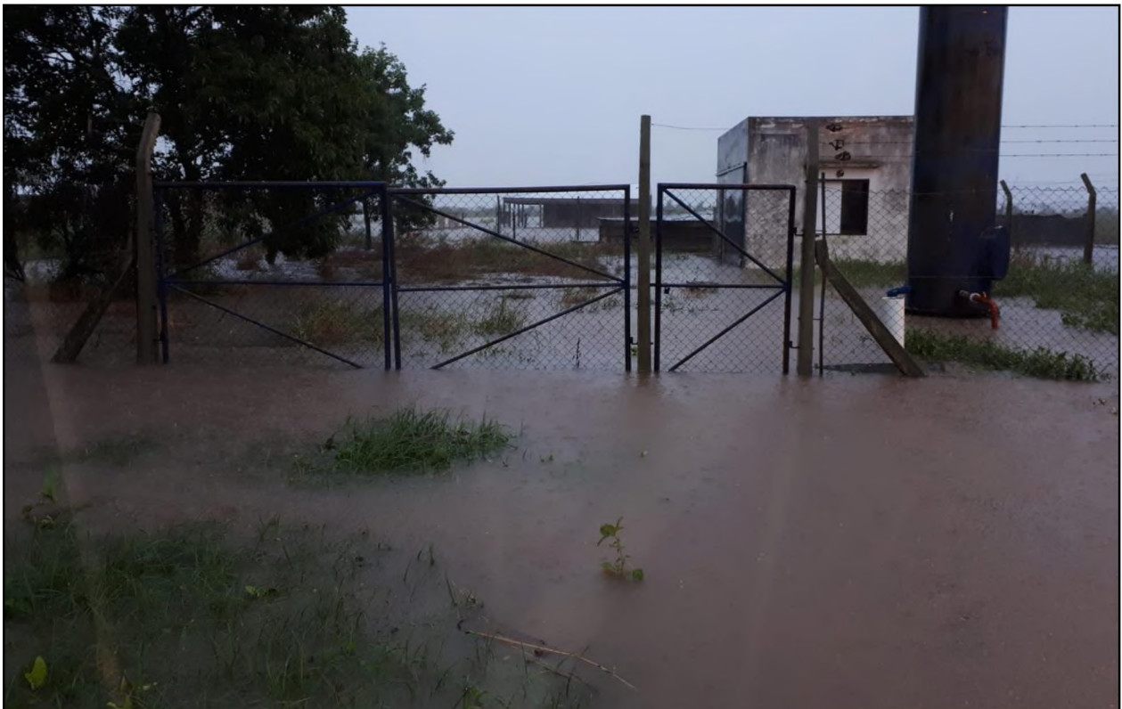
Fotografía 1.2. Planta de tratamiento y distribución de agua potable fuera de funcionamiento de la APA.
