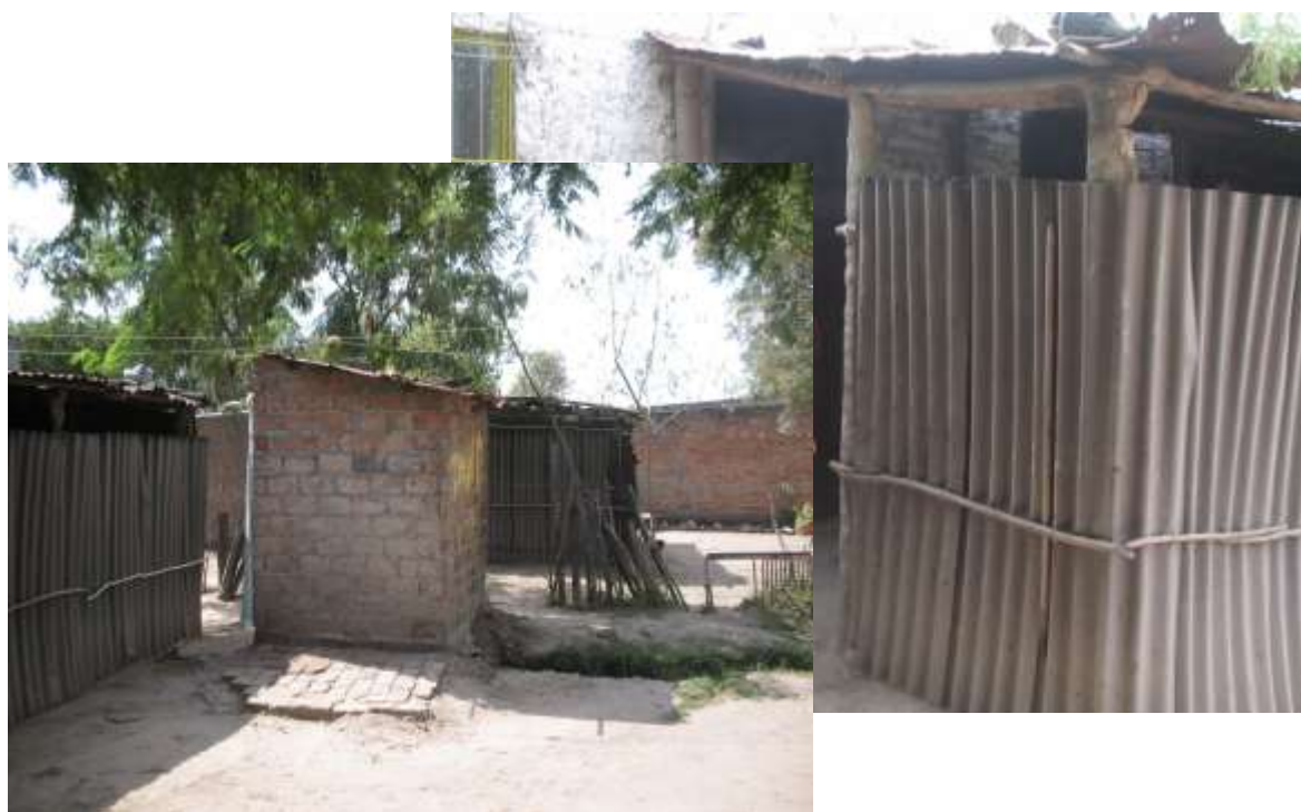
Figura N° 4. Fotografías que muestran el tipo de construcción mixta. (Foto del autor)
