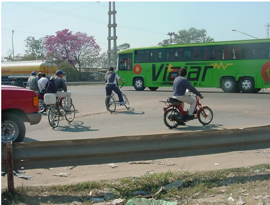
Presencia de distintos tipos de vehículos por uso inadecuado de las vías de circulación (Ruta Nacional 11 y Avenida Alvear):
