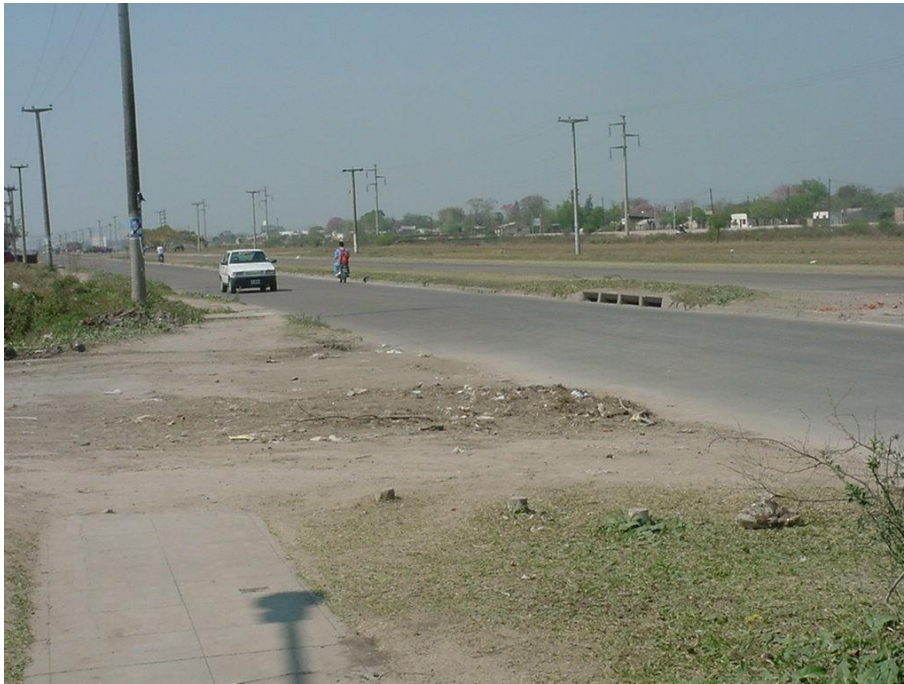
Ausencia de señales de tránsito (Avenida Islas Malvinas y Avenida Belgrano)
