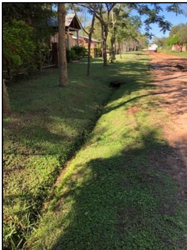
Figura 1.20. Zanjas a cielo abierto en calle de tierra (Fuente: elaboración propia).
