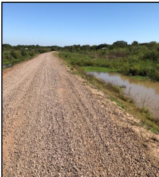
Figura 1.21. Defensa sobre el arroyo Huajó (Fuente: elaboración propia).
