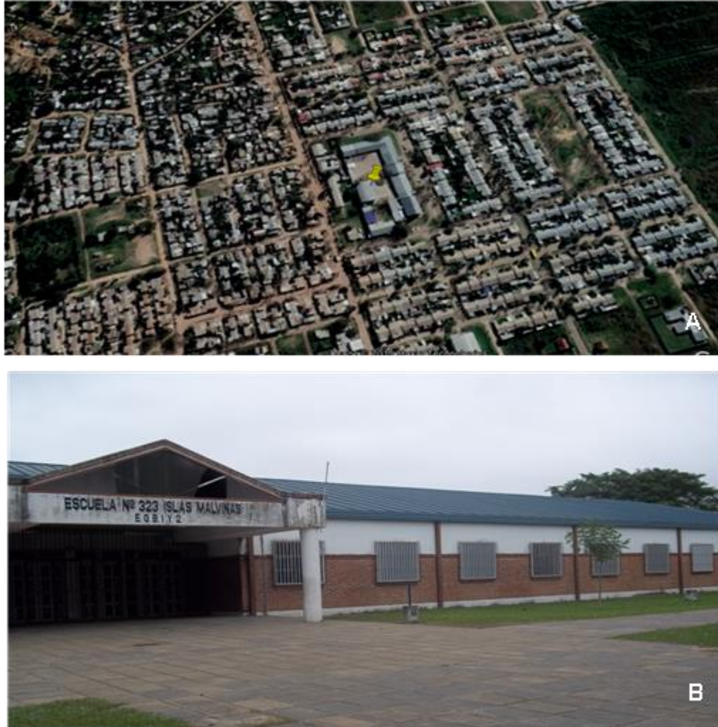
Fig. 3. Imagen de la Escuela Periférica. A) Vista satelital ( referencia: señalizada en amarillo ). B) Vista frontal.
