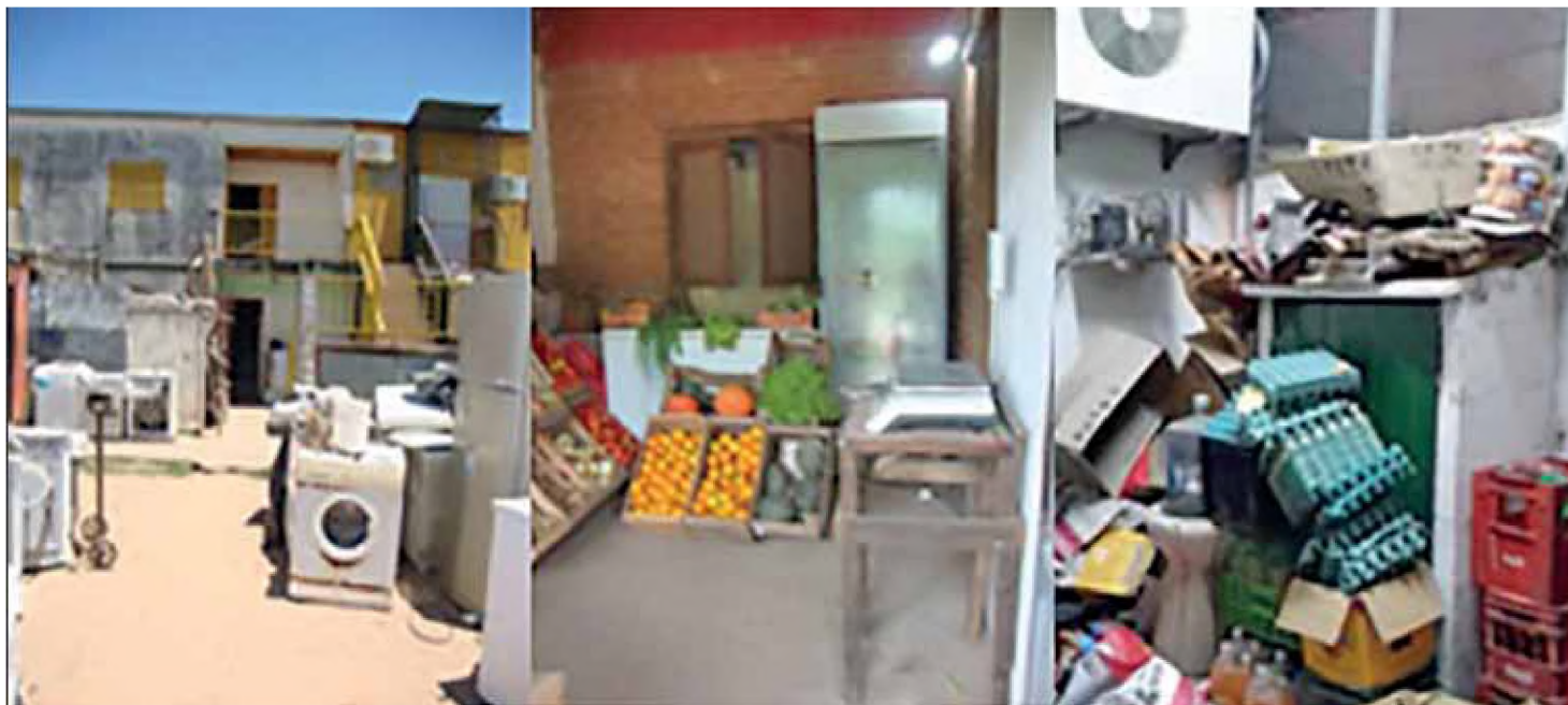
Figura 1. Afectación de las condiciones de habitabilidad a partir de las modificaciones de los espacios de habitar para la incorporación de prácticas económicas. Fuente: elaboración propia
