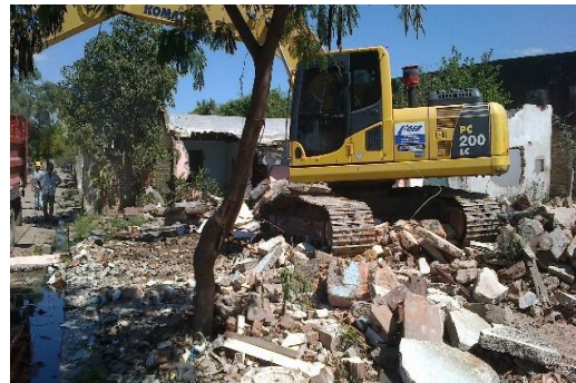
Foto N° 57: Demolición de las viviendas. Fuente: IPDUV
