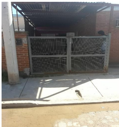
Foto N°13: Ampliaciones construidas por los propietarios Fuente: Producción Propia
