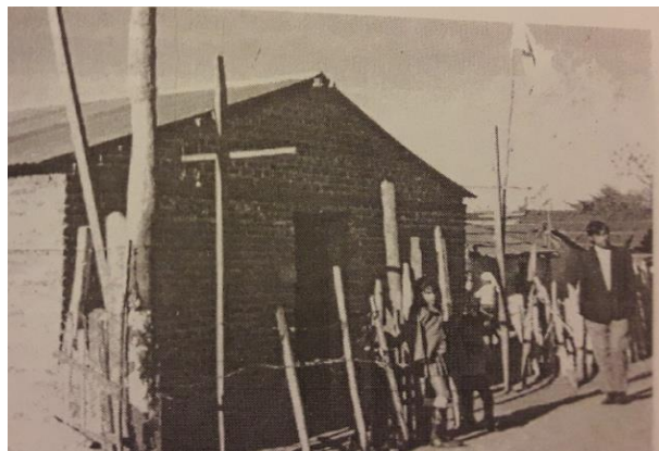
Foto N° 33: Vivienda aborigen urbana autoconstruida. Fuente: Imagen de Alejandro Isla
