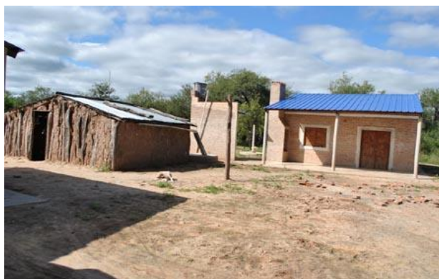
Foto N°38: Viviendas construidas por el estado para reemplazar viviendas-ranchos. Fuente: Página IDACH
