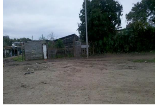
Foto N° 9: Asentamiento periférico al Barrio Toba. Fuente: Producción propia
