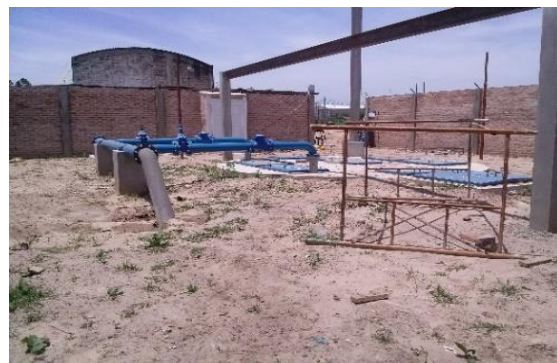
Foto N°64: Obra pozo de bombeo de cloacas Fuente: ProMeBa
