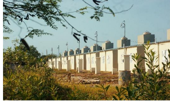
Foto N° 51: Viviendas B° Crescencio López Fuente IPDUV
