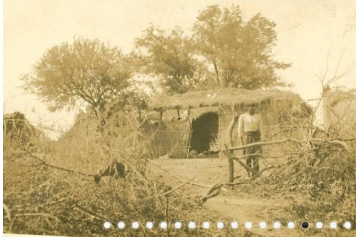
Foto N° 25: Chozas ejecutadas con ramas y pajas. Fuente: https://www.bing.com
