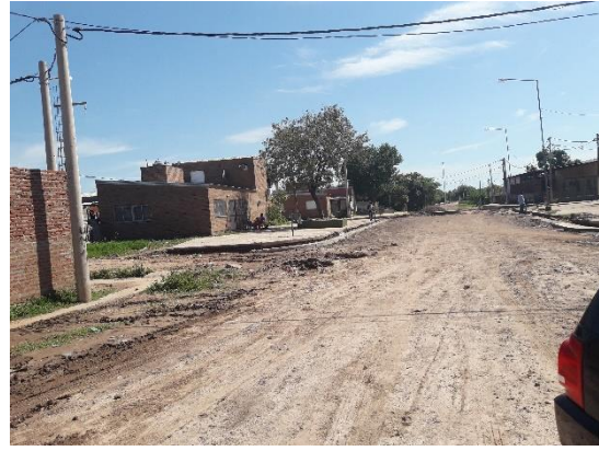
Fotos N°81: Calles perimetrales de tierra sin pavimentar Fuente: Producción propia
