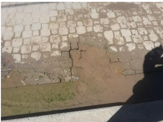
N°78: Perdidas de la red de agua y red de cloacas Fuente: Producción propia
