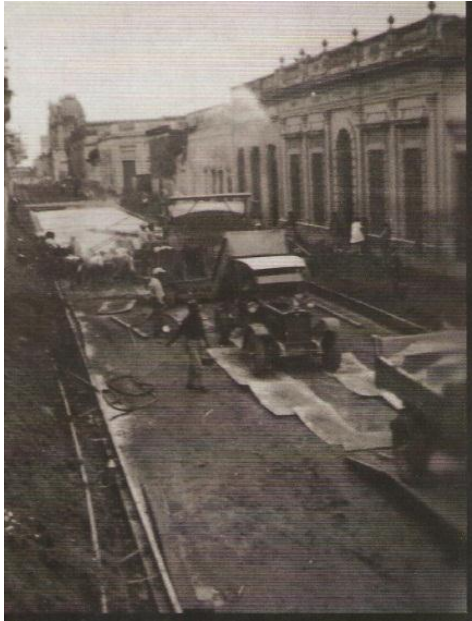
Pavimentación de la calle Quintana entre La Rioja y San Juan.
