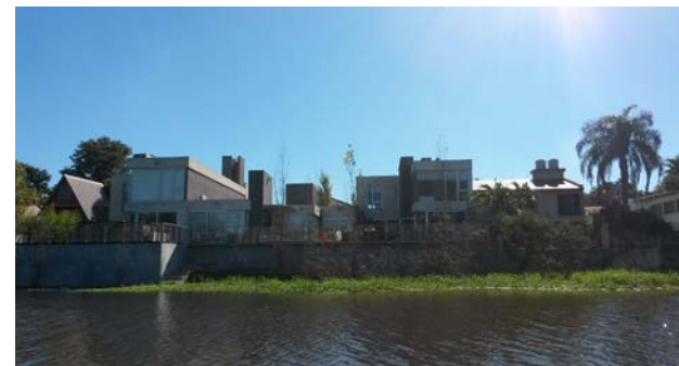
Fotografía 1. Vivienda construida sobre la Ribera del Río Negro
