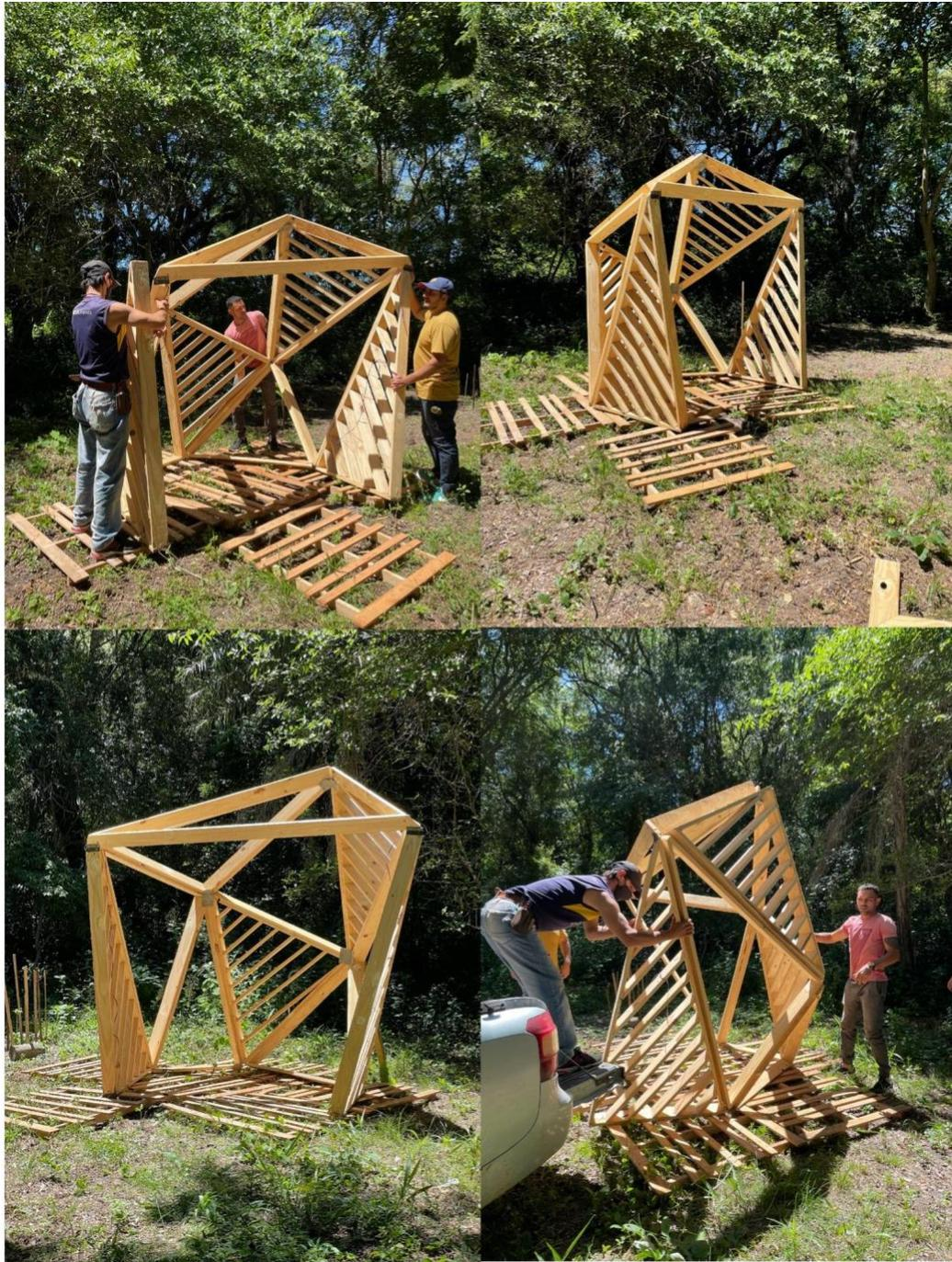
Posteriormente, se midieron las secciones y se cortaron las tiras de led y los difusores para montarlas en la parte interior de la estructura. Luego, se terminó la base de la estructura con maderas que fueron recolectadas en el lugar, se conectaron los cables y sensores en la interfaz Arduino y se realizó una prueba de testeo en base a los sensores que detectaban la temperatura y humedad en el momento. Por otra parte, teniendo en cuenta los
