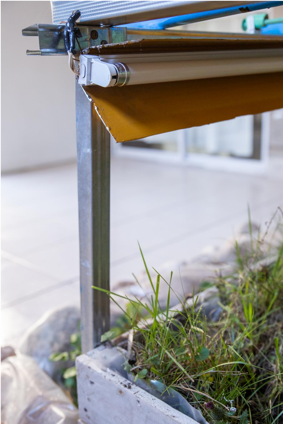
Fig. 52- Detalle del sistema de iluminación.
