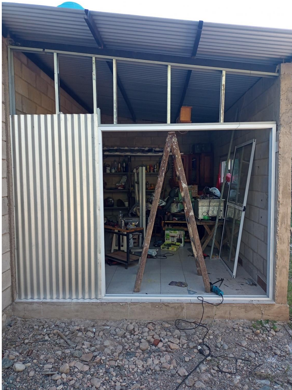
Fig. 42- Cerramiento de galpón.
