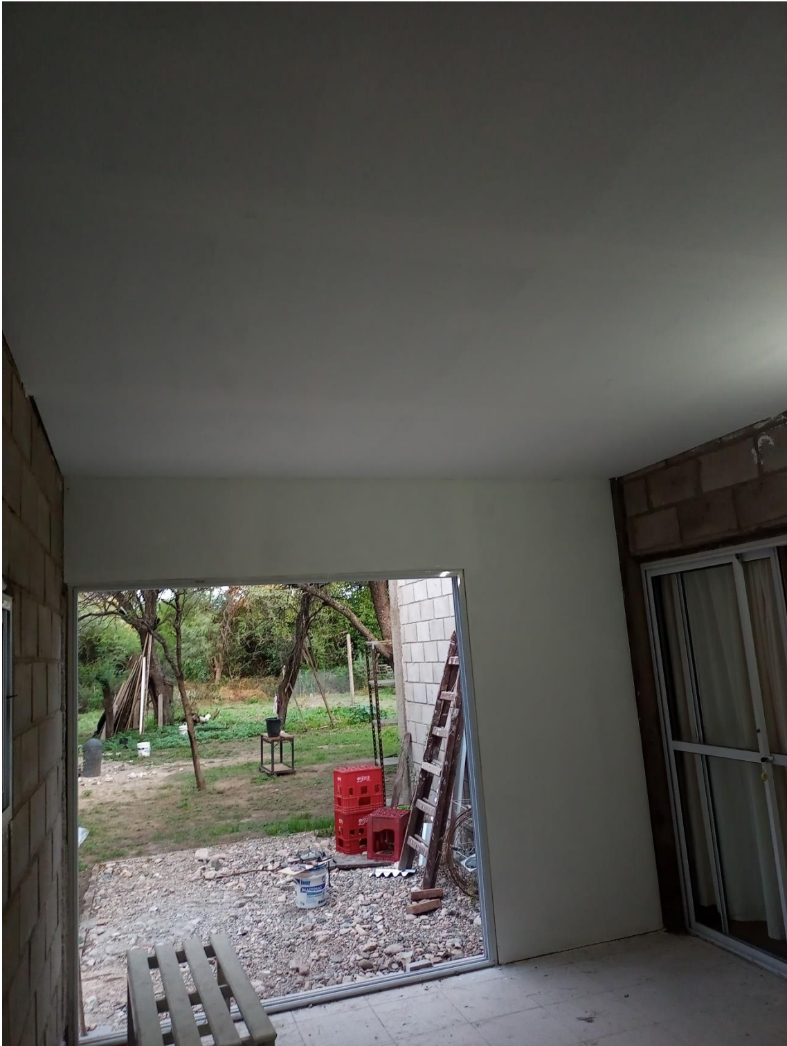
Fig. 43- Finalización de aislamiento del lugar con placas de yeso (luego se pusieron puertas de vidrio y cortinas gruesas).
