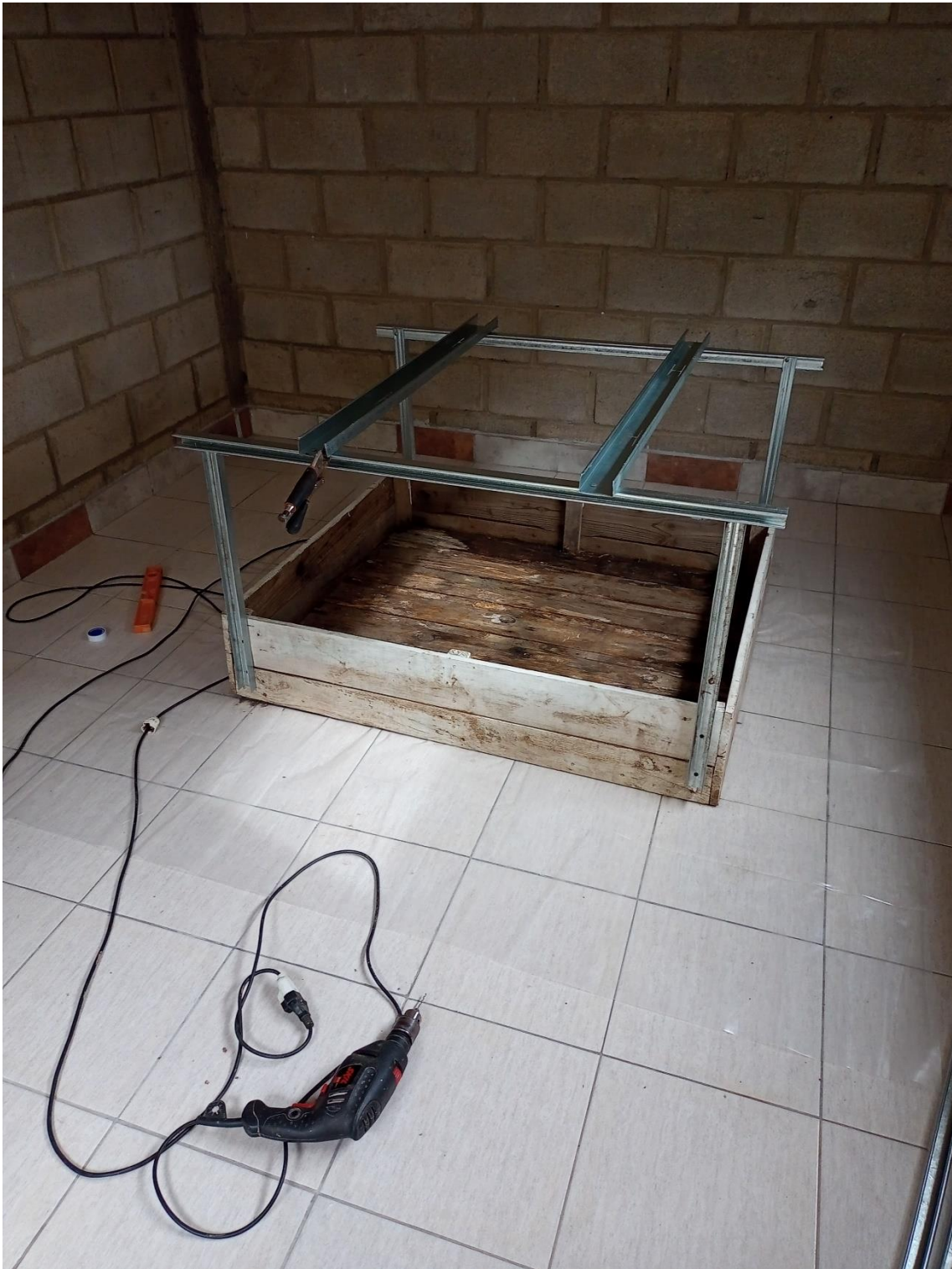
Fig. 44- Comienzos de la construcción de la Nature Machine para Prueba 2.
