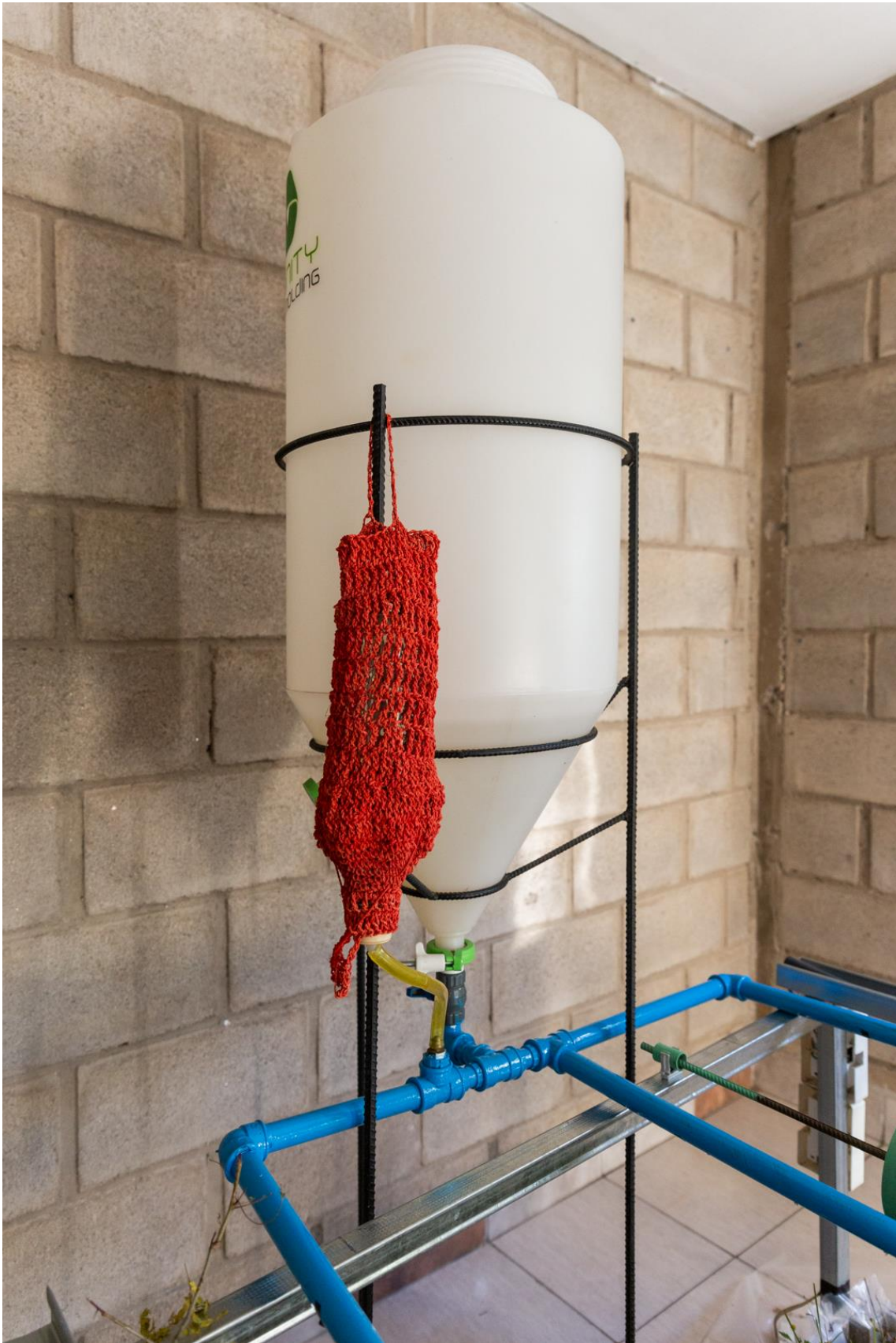
Fig. 49- Detalle del sistema de riego. El tanque blanco contiene agua. En rojo, se ve el recipiente con herbicida, envuelto en un tejido informe de fibra vegetal, como una masa cancerosa conectada a la red de agua.
