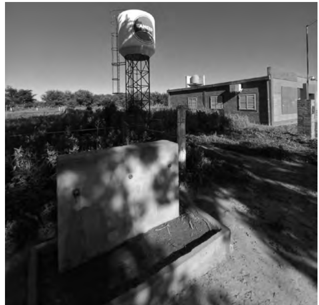
Figura 4. Tanque de agua y canillas comunitarias —bloqueadas y sin posibilidad de uso— construidas con financiamiento internacional del Banco Mundial en la Sala de salud de Campo Medina, Pampa del Indio, Chaco Fuente: fotografía tomada en trabajo de campo (diciembre de 2021)
