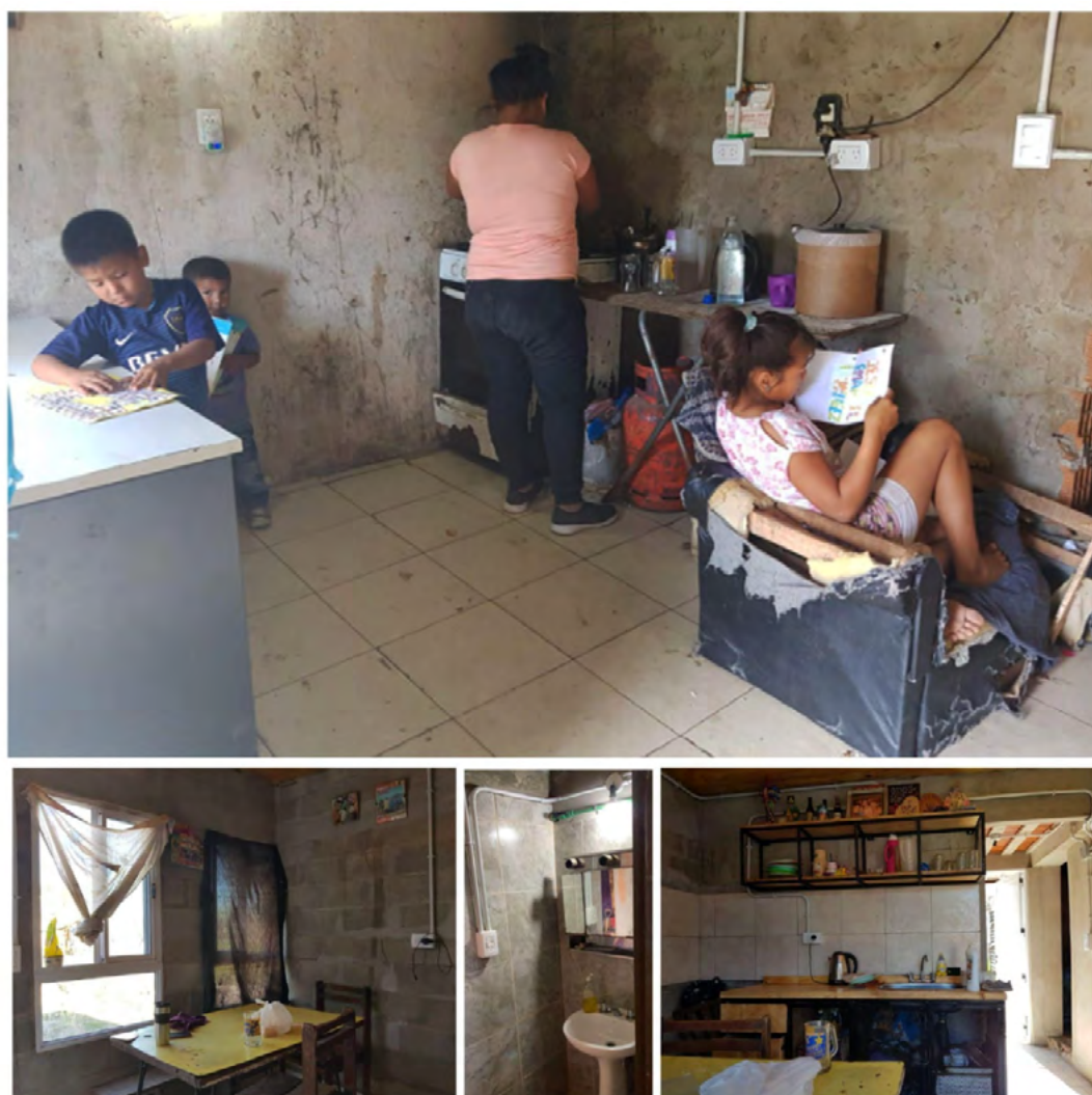
Figura 6. Vivienda existente e intervención de NH. Micaela Subelza (lote 13, manzana 1), barrio Bicentenario
