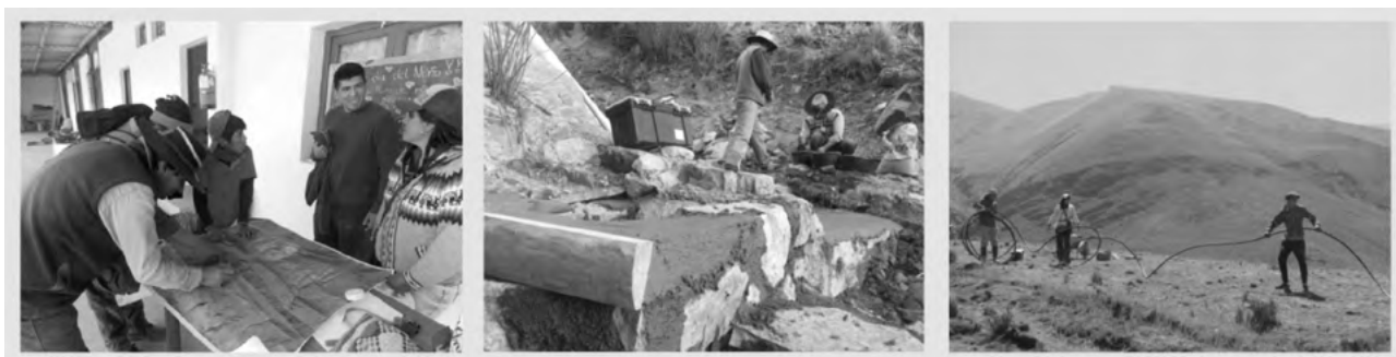
Figura 4. Realización de obras de agua multipropósito Fuente: fotografías tomadas por el grupo
