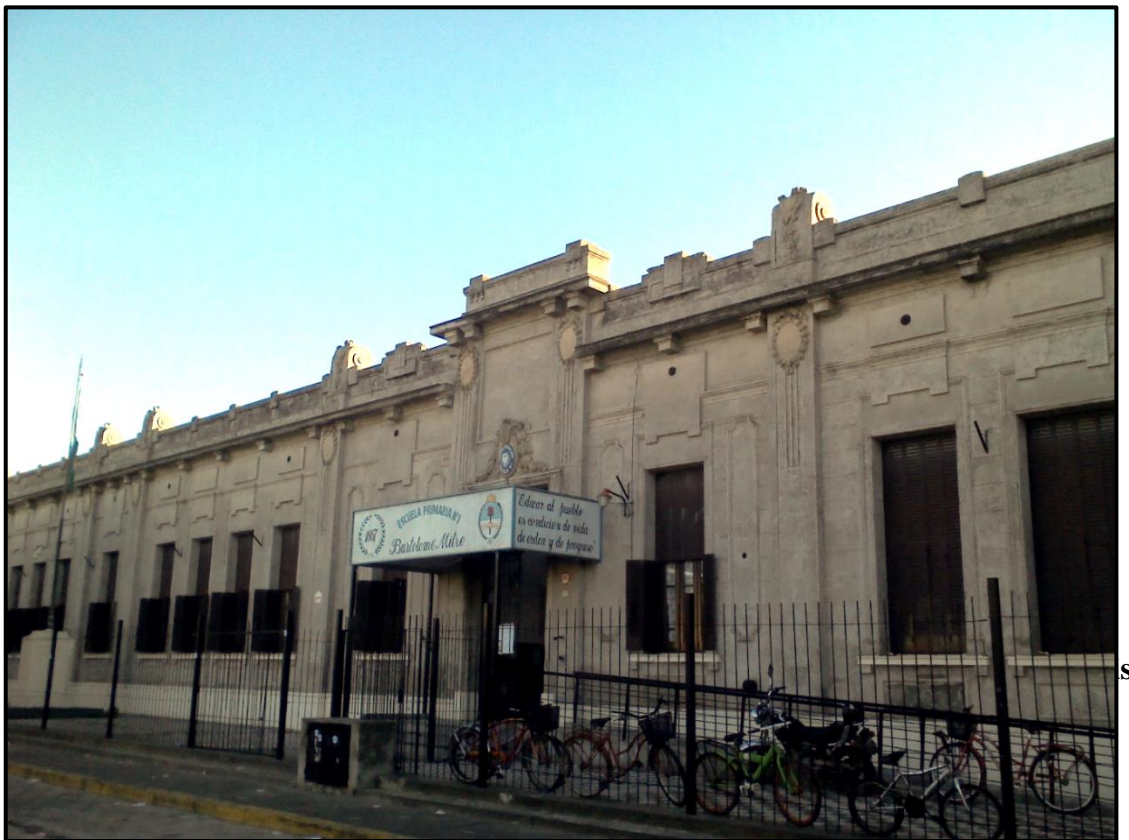
Figura 25. Escuela primaria N°1 Bartolomé de Mitre. Ubicada en la calle Sarmiento de la localidad General Rodríguez, provincia de Buenos Aires
