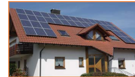
Aislada sistema solar casero
