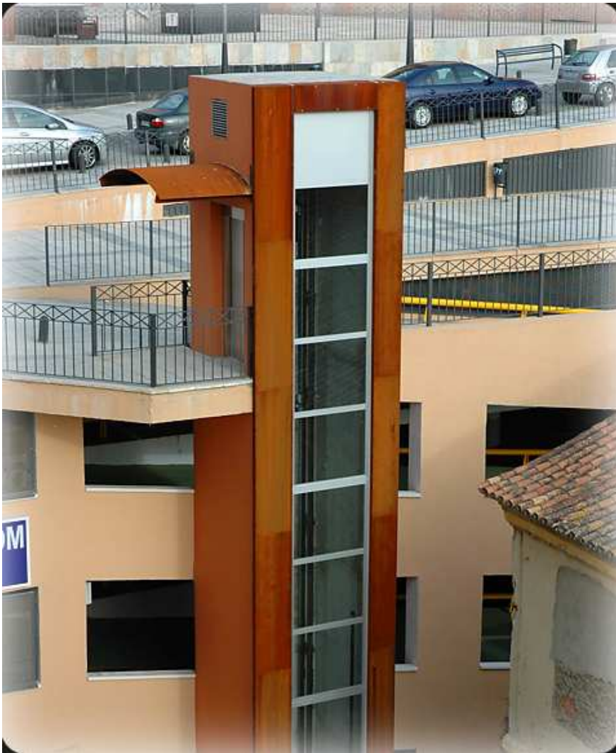
En este caso se ha utilizado como parte de la caja de un ascensor.
