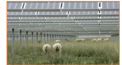
Granja solar de generación
