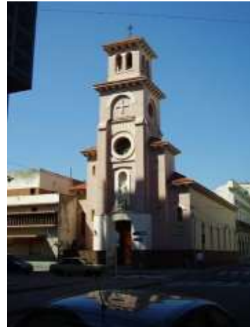
Fachada principal sobre calle San Juan.
