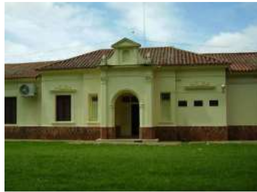
Fachada de uno de los pabellones sanitarios.
