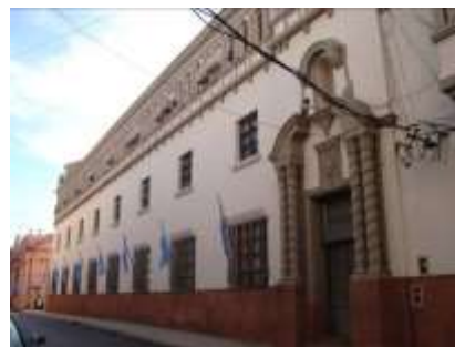
Fachada sobre calle Salta
