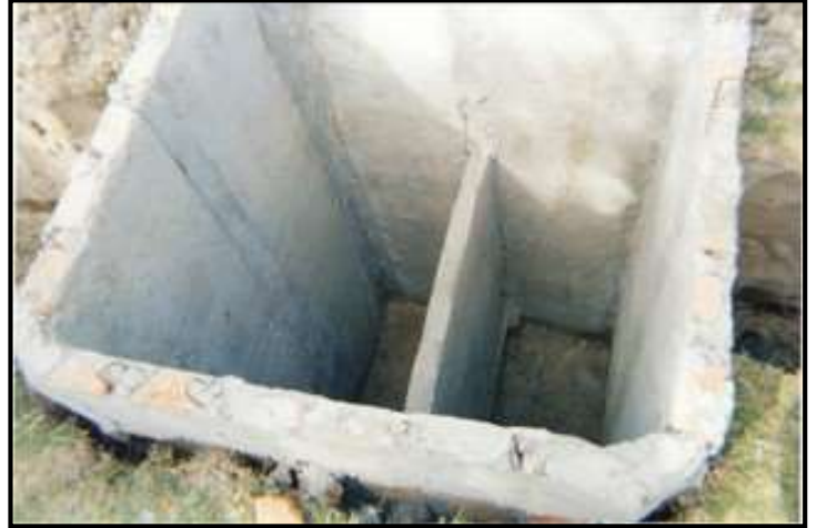
Imagen N° 49: cámara séptica
