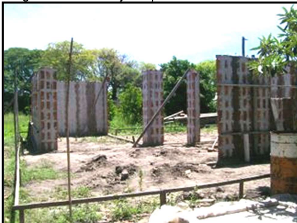
Imagen N° 42: montaje de placas
