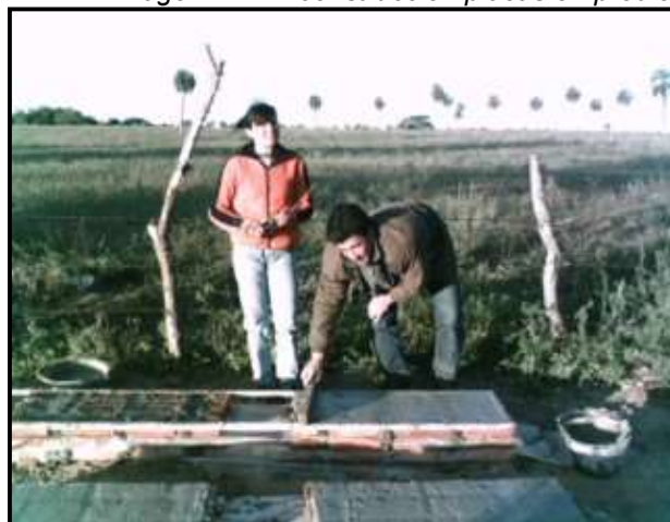
Imagen N° 41: construcción placas en predios
