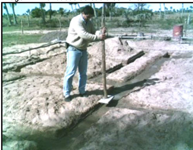
Imagen N° 40: bases de suelo-cemento
