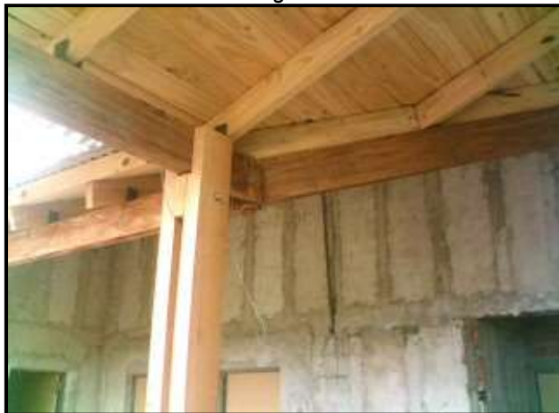
Imagen N° 47: detalle de techos
