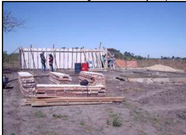
Imagen N° 43: montaje de placas
