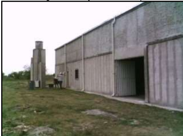
Imagen N° 39: ejecución del depósito central
