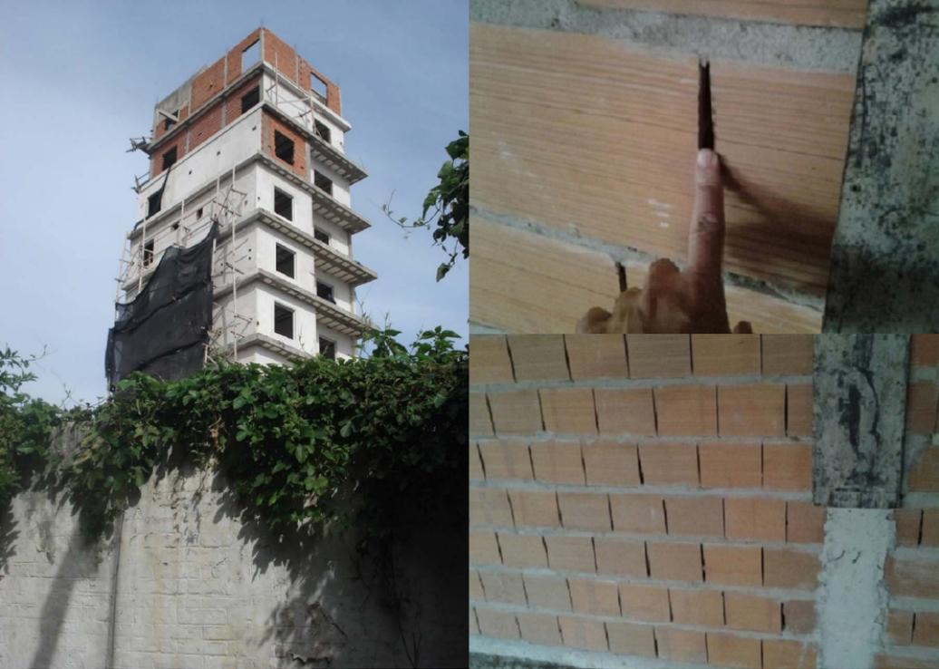
Figura 4: Tecnología FONAVI, en una obra del mercado inmobiliario privado. Se observa claramente que las juntas verticales no se llenan con la mezcla de unión, quedando la rajadura de aire en el interior del paramento.
