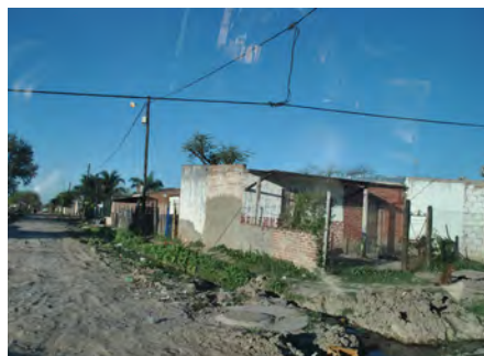
Figuras 18-19-20. Condiciones del espacio público en asentamientos irregulares del AMGR. Fuente: Imágenes propias entre 2013 y 2014.
