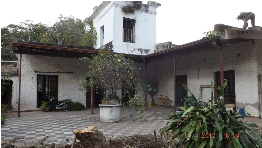
Figura 4- Vista Interior de galería y patio.
